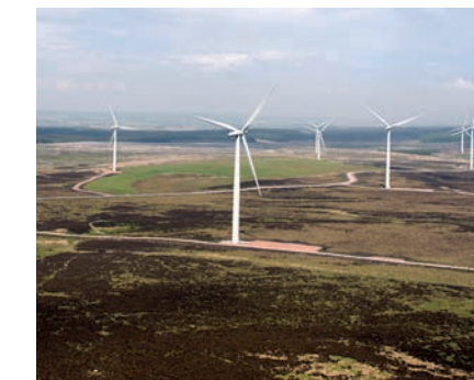
Siemens ligger i världstopp när det gäller kraftverk och distributionslösningar för vindkraft.
