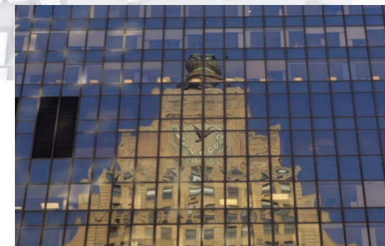
Energisparprogram och ny teknik höjer effektiviteten i både äldre och nyproducerade byggnader.
